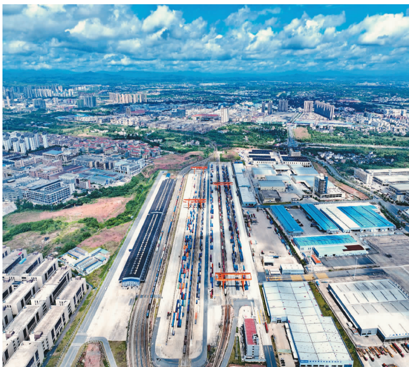
8月6日，位于江西省赣州市南康区龙岭镇的赣州国际陆港，龙门吊在来回装卸出口家具产品和进口木料的集装箱货柜。赣州国际陆港的“铁海联运”模式，畅通了南康家具出口外销渠道，尤其是中欧班列开通，将内陆城市赣州直接与“一带一路”沿线国家外贸接轨，融入国际国内物流大通道，南康家具产业也成为革命老区赣南振兴发展的核心增长极。
