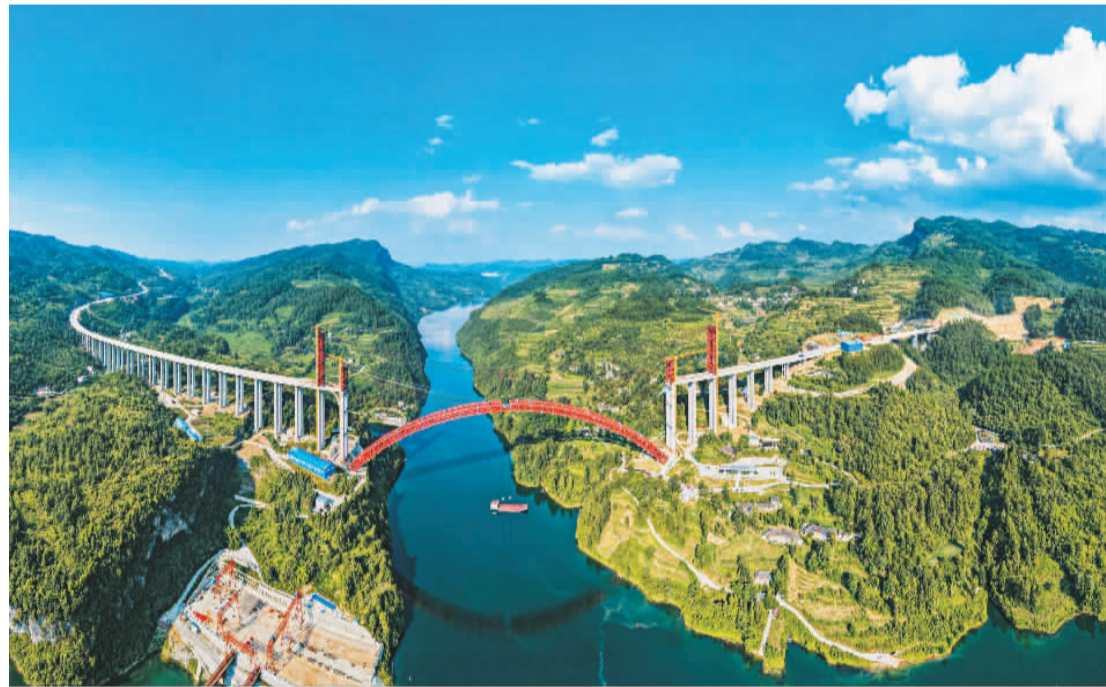
位于贵州省思南、石阡、凤冈三县交界处的德(江)余(庆)高速乌江特大桥目前建设正酣。该项目是德余高速控制性工程, 全长1834米, 主桥为504米上承式钢管混凝土拱桥。图为8月2日, 大桥主拱圈正在进行最后的吊装施工。 邓刚摄(人民图片)
