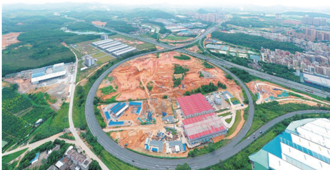
江鶴高速公路改擴建項目配套的鋼筋加工中心和水泥攪拌站。
