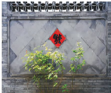
▲改造后的雨儿胡同30号院内影壁
