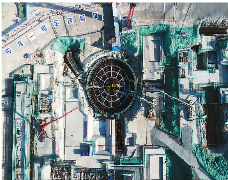
2021年7月13日，“玲龙一号”陆上商用模块化小型反应堆在海南省昌江黎族自治县开工。
