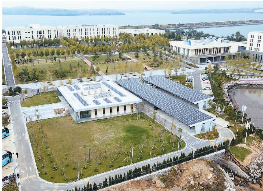
山东省荣成市石岛管理区“国和一号”智慧核能综合利用示范项目一期崮山光伏项目。
