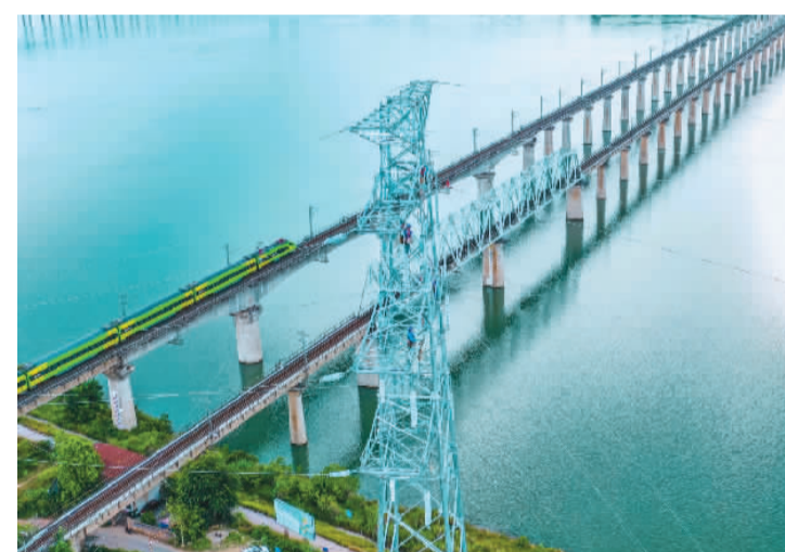
为配合四川省重点建设项目南充市将军路嘉陵江大桥新建工程建设，国网南充供电公司加紧实施110千伏望坝线、望坝线线路迁改工程。图为供电员工在85米高的新建铁塔上开展架线作业。 安伟摄（人民视觉）
