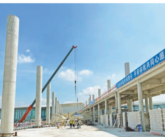
白雲機場三期擴建工程西四指廊施工現場。廣東省機場集團供圖
