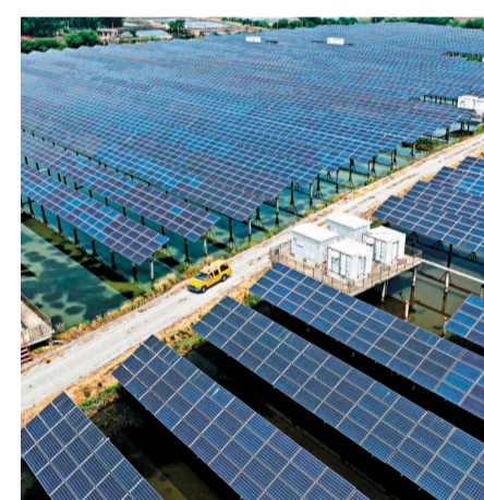
◆ 中國清潔能源在能源消費增量中的份額已超過60%。圖為江蘇揚州市江都區武武鎮曹橋村的漁光互補發電項目。 資料圖片
