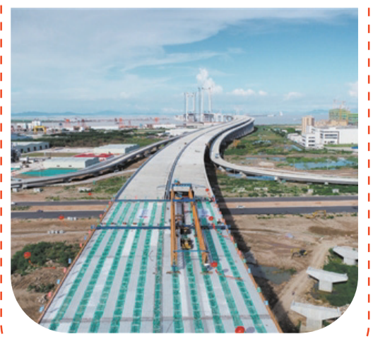
中開高速橫門互通主線橋與深中通道實現順利對接。
