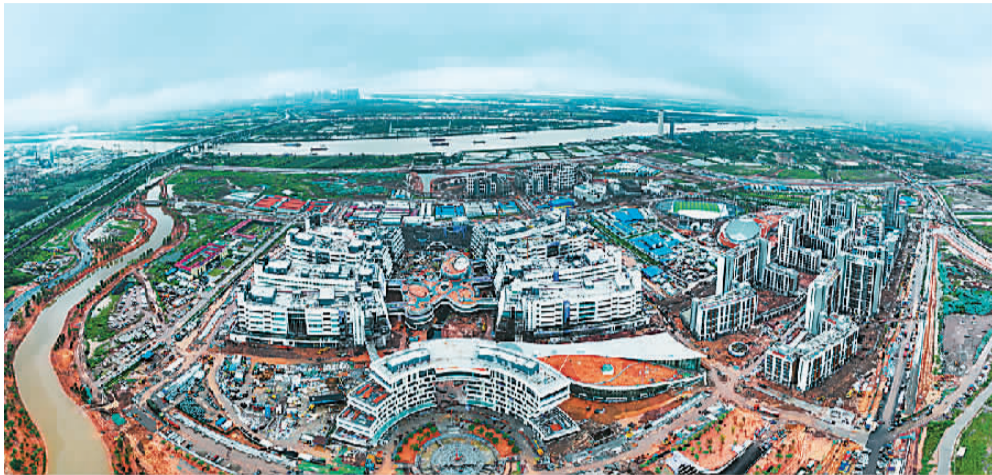
近日，位于广东省广州市南沙区的香港科技大学（广州）项目正紧张有序施工。作为粤港澳大湾区建设的重点工程，项目建成后将成为香港与内地全面深入合作的重大科技创新平台和培育国际化高端人才的集聚高地。 付海燕摄（人民图片）
