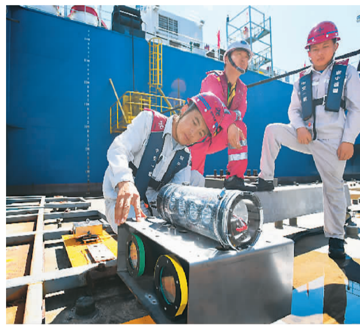
由中交一航局施工的深中通道E19沉管近日在珠江口伶仃洋海底成功实现毫米级对接。在此次沉管隧道安装中，项目测绘团队进行了一项水下精准定位技术创新试验，为沉管在海底安装对接提供更加可靠、更高精度的定位数据。深中通道海底隧道全长6845米，其中沉管段长5035米，由32节沉管和1个最终接头组成。
