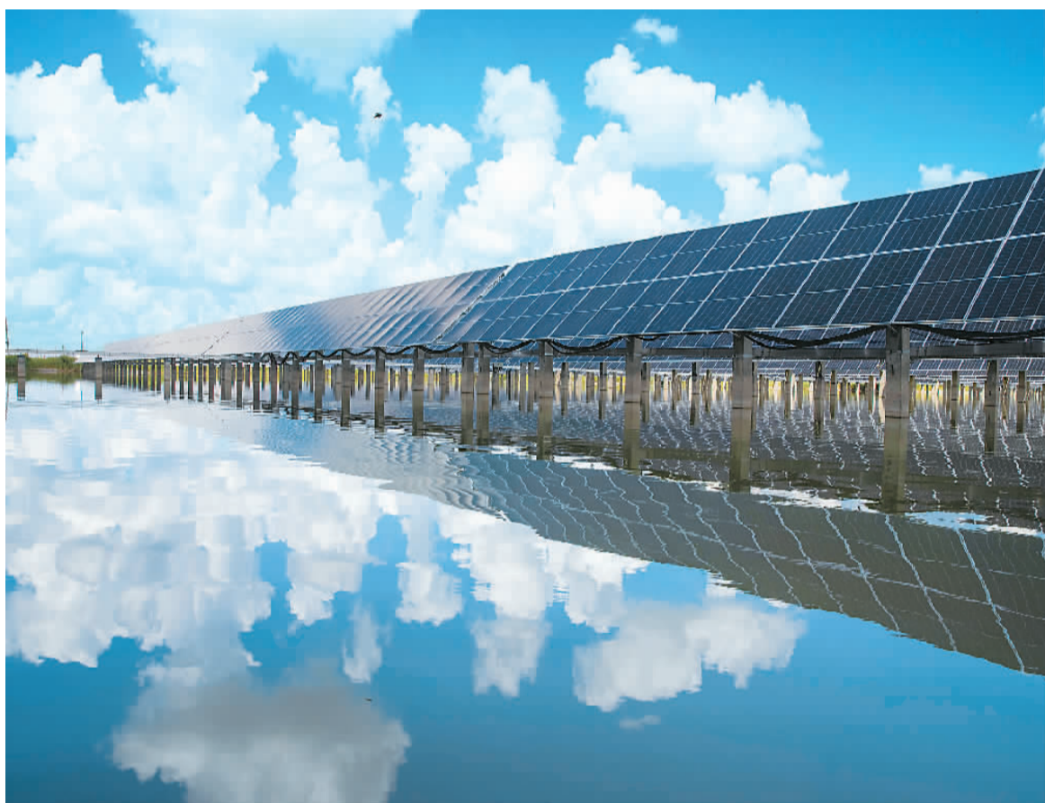
大庆油田星火水面光伏项目并网发电 日前，中国石油首个水面光伏项目——大庆油田星火水面光伏示范工程完成自主设计建设水面光伏的成功探索，实现并网发电。据介绍，该项目利用两个水面，建设用地40万平方米、装机规模18.73兆瓦，年均发电2750万千瓦时、减排二氧化碳2.2万吨，助推“油城”新能源发展再次提速。图为近日拍摄的示范工程现场。
