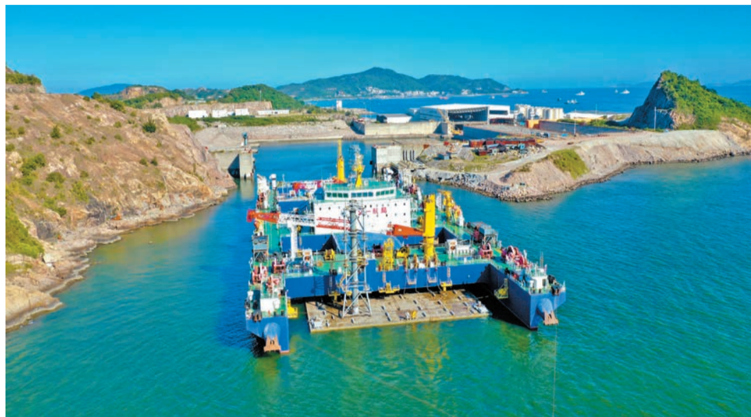
沉管浮運安裝一體船正提帶E19管節前往隴址。 盧志華 攝
