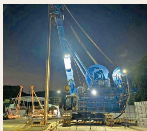
廣花城際施工現場。 廣州地鐵供圖
