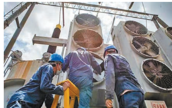
為確保變壓器穩定運行，南方電網深圳供電局變電工作人員在炎夏的戶外開展變壓器冷卻系統檢修工作。黃海鵬攝
