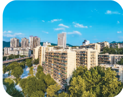
重庆北碚区新房子片区老旧小区改造完工后焕然一新。秦廷富摄（人民视觉）
