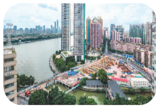
滨江东路上的广州地铁十号线施工中的广州地铁十号线。新华社记者 刘大伟 摄
