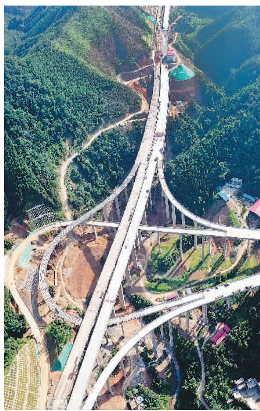
日前贯通的广西规模最大、墩身最高的枢纽互通——贵州平塘至广西天峨高速公路天峨枢纽互通。高东风摄(人民视觉)
