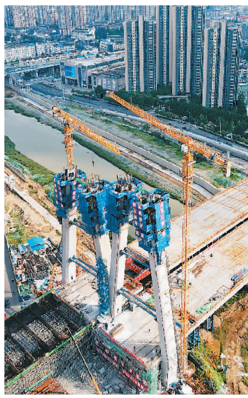
7月22日,工人在中铁四局引江济淮工程江淮沟通段金寨南路桥项目现场错时施工。新华社记者 刘军喜摄
