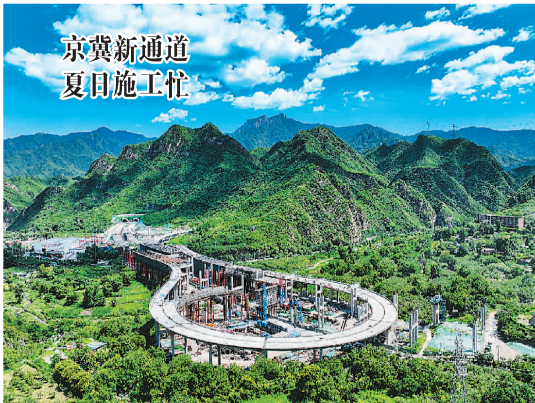
作为京津冀协同发展交通一体化重点项目,国道109新线高速项目工程(北京段)目前正在加紧施工,预计明年年底实现主体工程完工。该线路东起西六环庄立交,西至京冀交界处,与河北省张涿(张家口—涿州)高速公路相接。项目竣工后将成为北京西部首条连接河北省的高速公路,有助于带动相关区域经济发展。图为工人在项目上施工。
