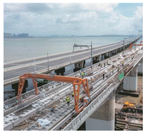
泉州灣跨海大橋無砟軌道施工現場
