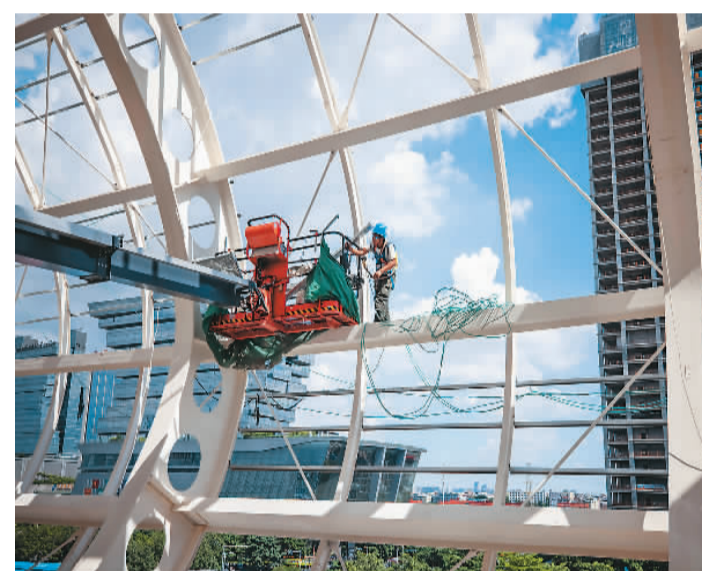
位于广东省广州市海珠区的广交会展馆四期扩建项目总建筑面积约56万平方米，建成后新增展位6000多个，是广交会展馆建设史上规模最大的扩建项目。目前，展厅、会议中心及东登录厅、西登录厅上建主体结构均已封顶。图为7月8日，建设者正在进行展馆的钢结构涂漆涂装作业。
