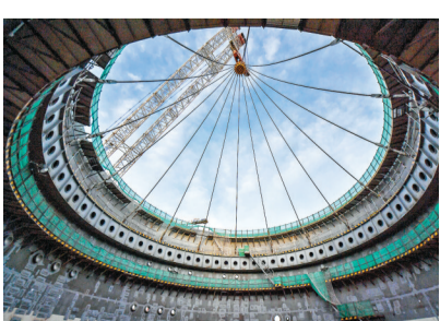
◆「玲龍一號」反應堆廠房鋼製安全殼上部筒體順利吊裝就位。圖為7月5日拍攝的筒體內景。中新社
