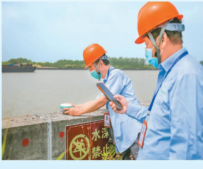
▲6月21日，上海市黄浦江上游堤防巡察员们加强巡察力度，维护堤防安全。图为堤防巡察员们正在测量堤岸下沉和偏移情况。
