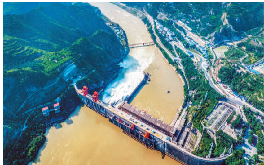
汛前黄河调水调沙日前开始实施，万家寨水库、三门峡水库正加大下泄流量，在小浪底库区形成高含沙水流，塑造并重流并排出库，以改善小浪底库区淤积。图为7月5日河南省三门峡市三门峡水利枢纽工程调水调沙现场。薛俊摄（人民视觉）
