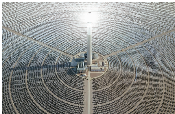
6月8日在海西蒙古族藏族自治州德令哈市光伏（光热）产业园拍摄的青海中控德令哈50兆瓦光热电站。
