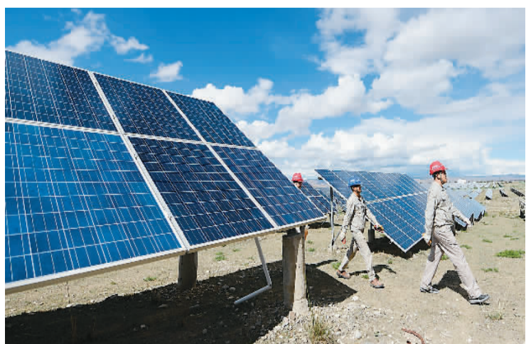
6月26日，大唐青海能源开发有限公司工作人员在青海省海南藏族自治州共和县塔拉滩光伏电站建设。
