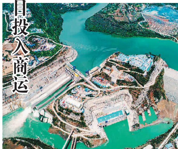
巴基斯坦卡洛特水电站鸟瞰图。唐鹏飞摄（中国三峡集团供图）
