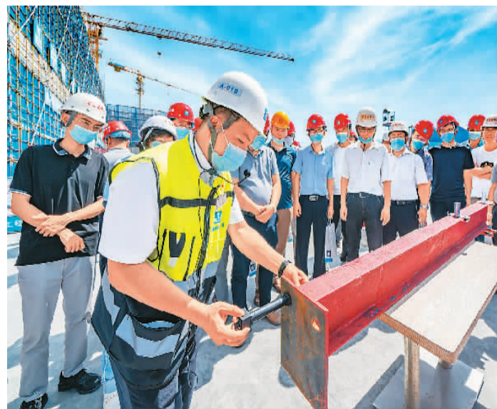
日前，2022年广东汕头市建筑施工“安全生产月”现场观摩交流会在中建八局南方公司汕头市中心医院易地重建项目举行，重点介绍降低安全隐患的新工艺。近年来，汕头市建筑行业坚持技术创新，通过技术手段降低工人在安装过程中的风险，保质保量完成工期进度。图为技术人员在讲解工字钢安装新工艺。梁波摄（人民视觉）
