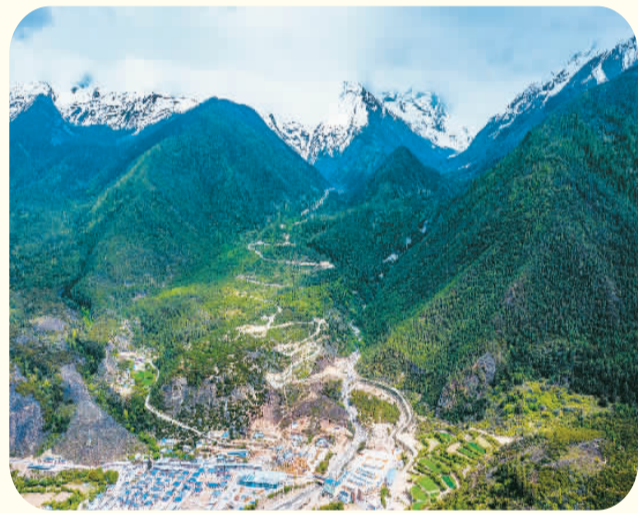
派墨公路全线贯通，进一步解决了高原孤岛——西藏墨脱县的交通瓶颈。图为派墨公路。 鲜敢、董志雄摄
