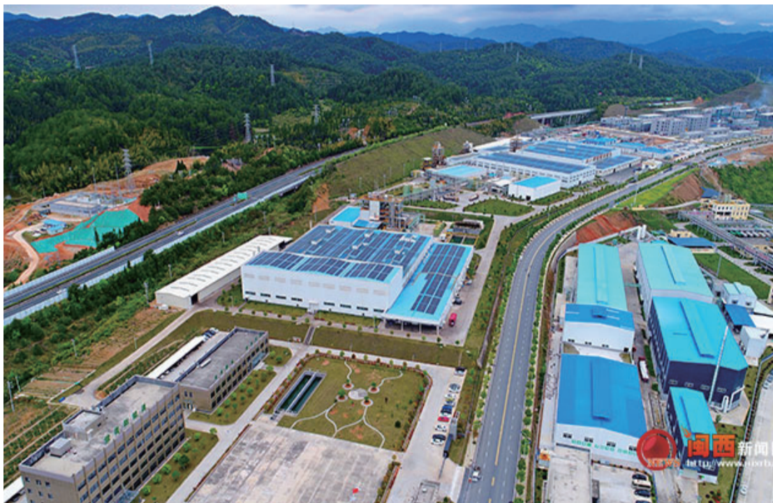
上杭蛟洋工業園區一角
