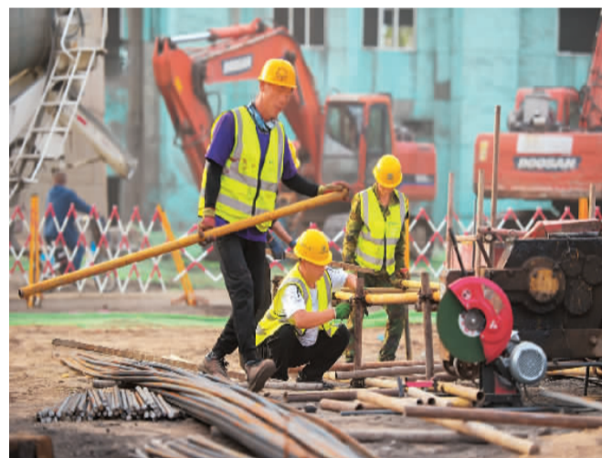
6月24日，内蒙古自治区包头市友谊十九小区改造现场，工人们在工地上忙碌。
