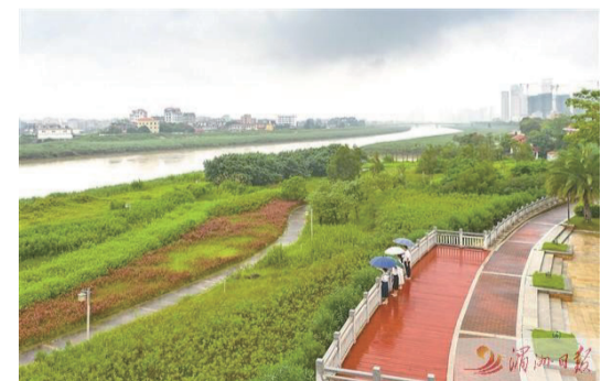
6月17日下午，木蘭溪防洪工程奠基點，有市民在賞景。雨中的木蘭溪，一派安然的景象。涇洲日報記者 蔡昊 攝
