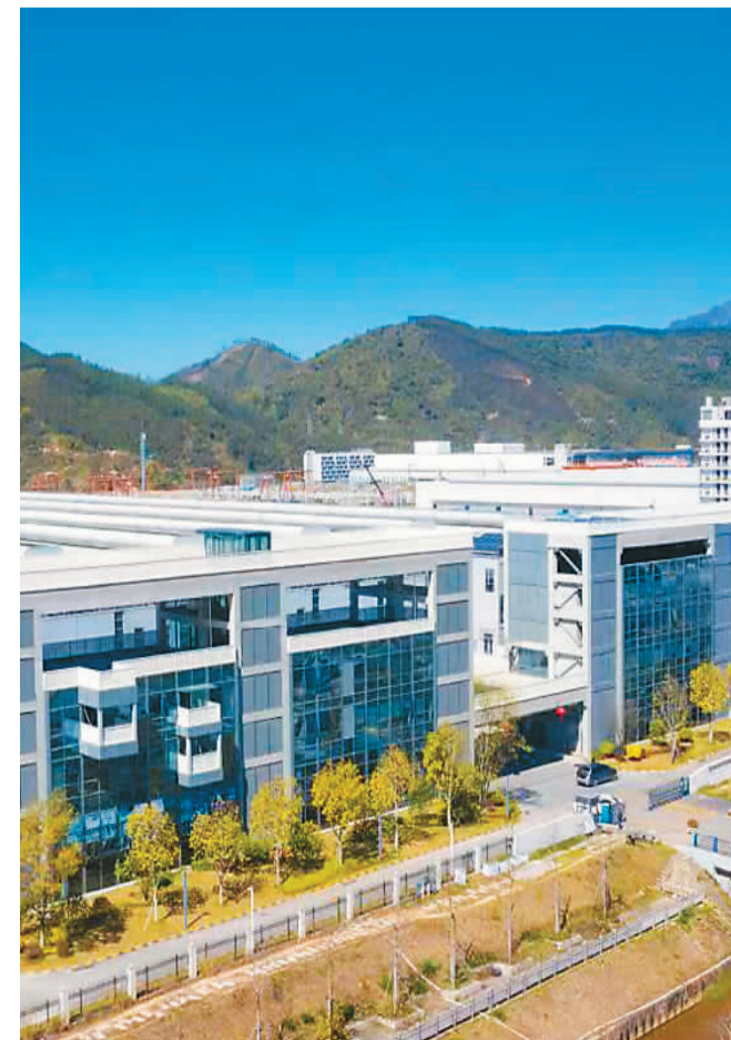
图为深汕特别合作区中建绿色产业园办公楼。
