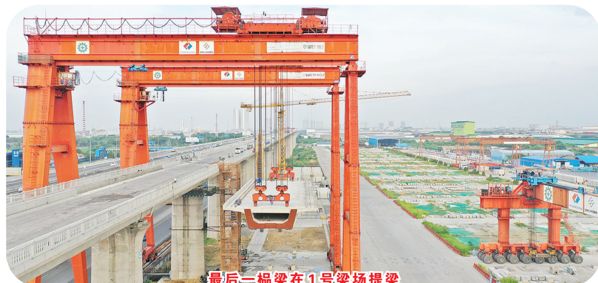
最后一榀梁在1号梁场提梁
