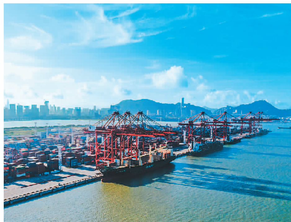
大铲湾码头位于广东省深圳市宝安区，紧邻大铲湾片区及前海深港现代服务业合作区，陆路可畅通无阻地往返珠三角制造基地，水路无缝连接珠三角西货源地。图为大铲湾码头一片忙碌景象。鲍贛生摄（人民视觉）
