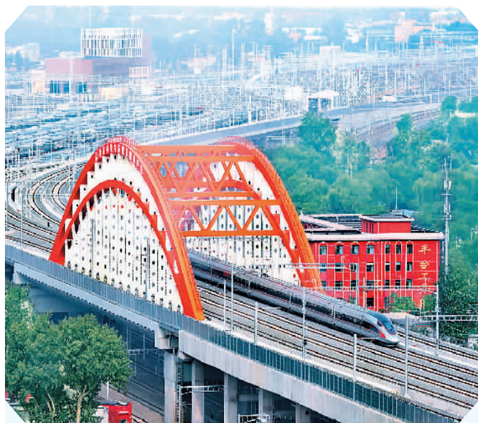
6月20日，G601列车作为北京丰台站驶出的第一列高铁列车行驶在丰台特大桥上。 周宇杰摄（人民视觉）
