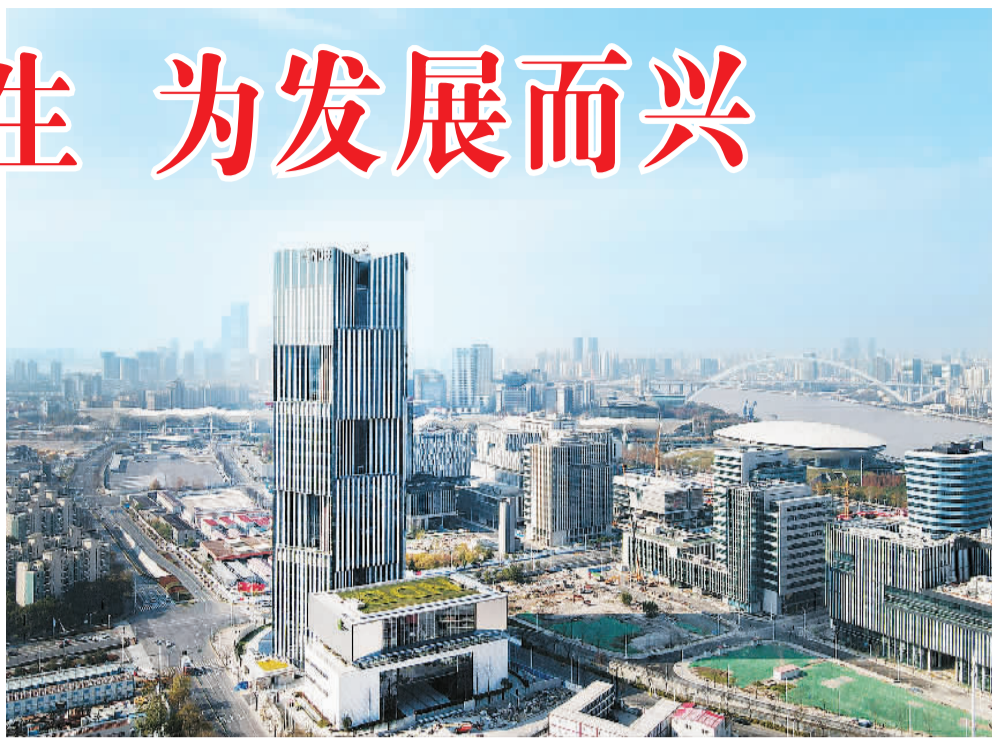
图为位于上海世博园区的新开发行总部大楼。(2020年12月17日摄。新华社记者方喆摄)
