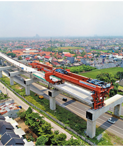
◆ 雅萬高鐵早前順利完成跨高速公路箱梁架設工程。網絡圖片
