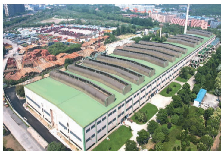
6月8日，从空中俯瞰浙江省杭州市杭钢云计算数据中心。
