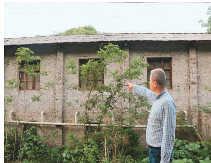
▲ 谢林港镇清溪村一处即将被拆除的猪舍。 新华社记者 丁春雨 摄
