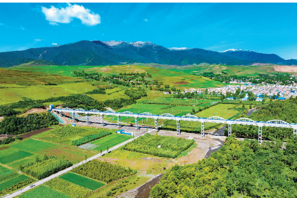
青海省引大济湟水利工程主体建设项目近日进入收官阶段。引大济湟工程从青海省东北部大通河调水引入湟水河，建成后有效保障群众生产生活用水需求，助力青海生态保护和高质量发展。图为日前拍摄的引大济湟工程西干渠4号渡槽，全长1331米。
