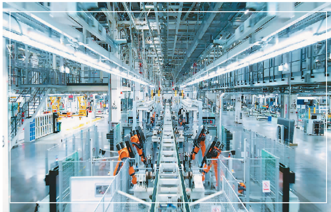
图为2021年12月21日，华晨宝马沈阳铁西新工厂进行设备安装和调试。
