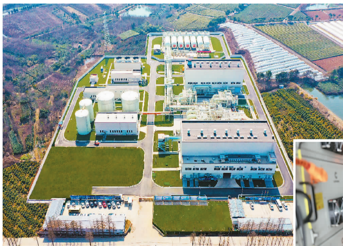
▲ 江苏金坛盐穴压缩空气储能项目外景,这是世界上首个非补燃压缩空气储能电站。
