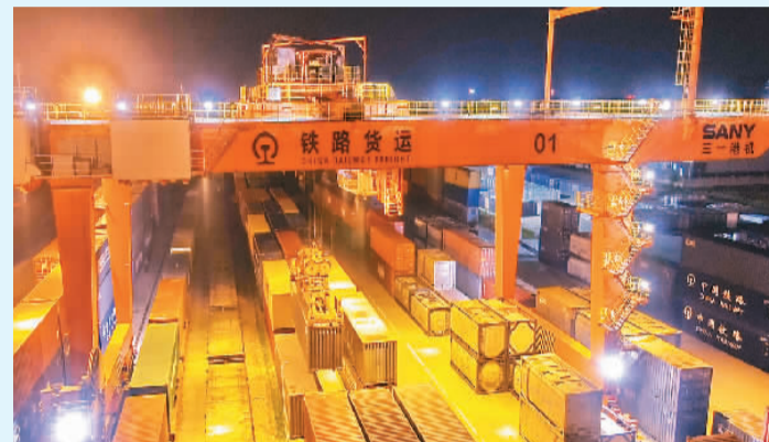
2022年4月30日，江苏省海安铁路物流基地集装箱吊正在装运中欧班列（海安—东盟）集装箱。 许丛军摄（人民视觉）
