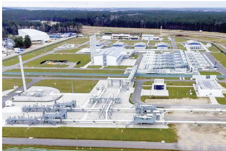
资料图：“北溪-2”天然气管道项目登陆设施管道。
