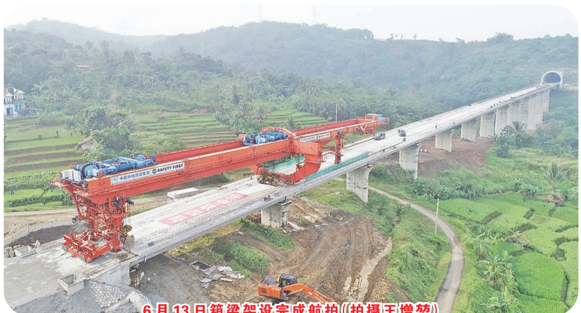
6月13日箱梁架设完成航拍(拍摄王增望)
