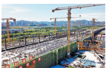
◆6月6日，施工人員對濟萊高鐵路城站混凝土主體結構進行封頂作業。資料圖片
