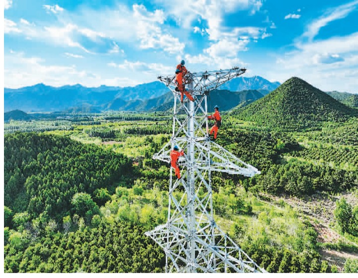
“十四五”期间,北京将持续优化能源结构,大幅提升绿电占比。到2025年,北京外调绿电电量力争达到300亿千瓦时,助力低碳发展。图为北京电力工程公司工人正在加紧建设西智35千伏变电站升压工程。 本报记者 贺勇摄
