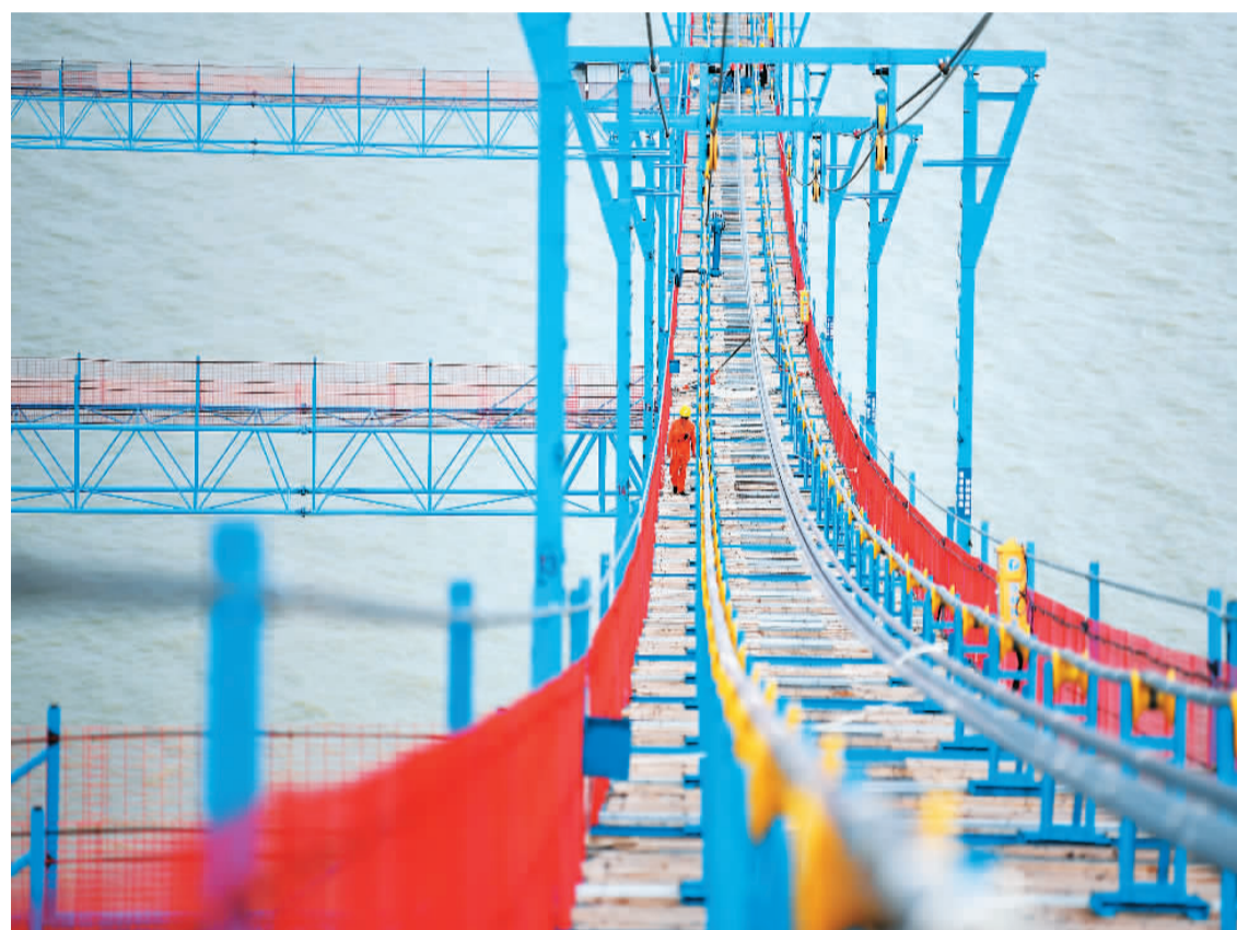
日前,工人在深中通道的伶仃洋大桥海上施工猫道上作业。据了解,深中通道路全长24公里,预计2024年建成通车,建成后将成为连接珠江口东西两岸的直连通道。 新华社记者 邓华摄
