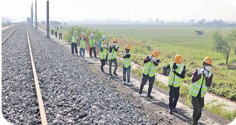
雅万高铁接触网附加线拉线施工
