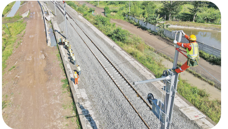
雅万高铁接触网专业架设附加线
