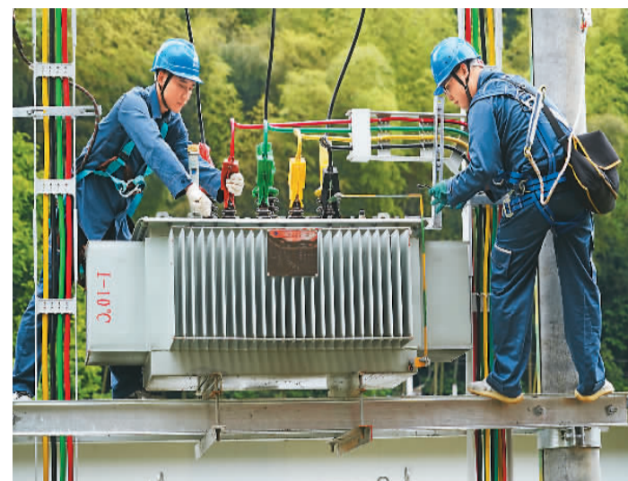
为确保夏收时期农业生产用电，贵州省铜仁市江口县供电公司近来组织工作人员来到江口县粮食储备仓五里桥粮站，对用电线路进行全面巡查，及时消除隐患，并根据负荷增长情况对变压器进行扩容扩容，保障夏收粮食安全入库。图为南方电网江口供电局工作人员对该粮站辖区的变压器进行扩容扩容作业。
