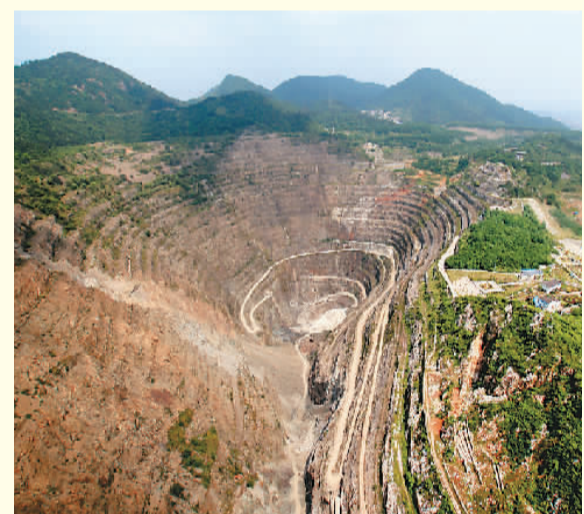
图为大冶铁矿露天采场旧址。
