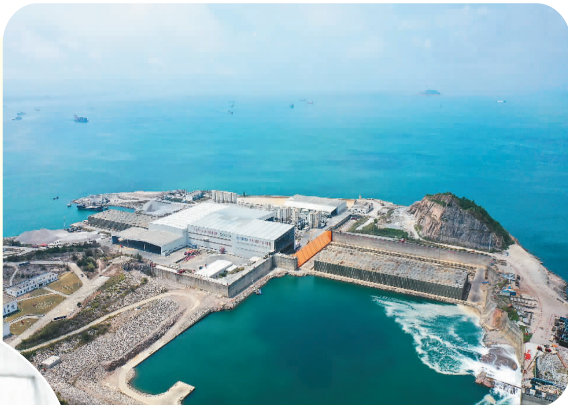
▲ 深中通道3节隧道沉管齐聚中交四航局牛头岛沉管智慧工厂。 新华社记者 刘大伟摄
