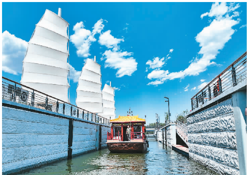
日前,随着最后一轮船舶过闸实验结束,位于京杭大运河上的杨洼船闸已具备通航条件,为京冀通航奠定了基础。杨洼船闸是京杭大运河京冀段通航的关键节点工程。图为船舶正在通过杨洼船闸。
