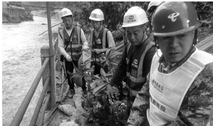
抢修现场。 中国电信四川公司供图
