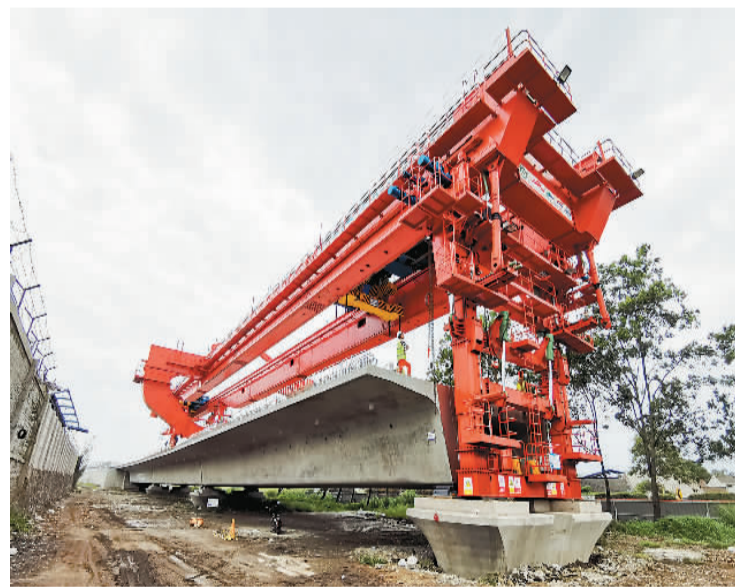
为雅万高铁量身打造的JQS900架桥机。
