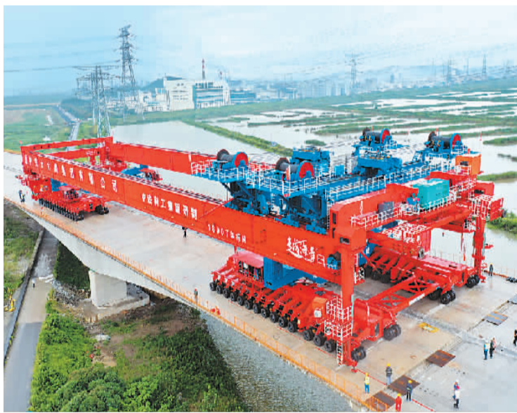
世界最大吨位1800吨级整孔预制箱梁架桥机“越海号”。中铁科工供图
